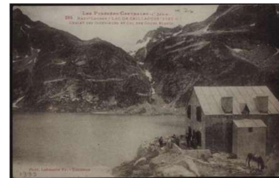
Figure 36 : Maison des ingénieurs au lac de Caillaouas pour la gestion hydraulique (1933) Source : P. Labouche
